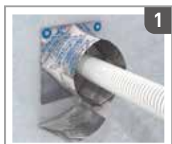
NEOシートの仮固定
